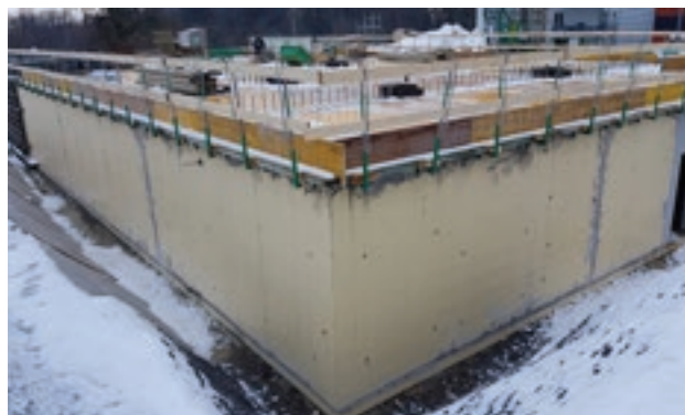
Otvorený výkop s SikaProof® A+, po odstránení debnenia musia byť utesnené otvory prechodu kotiev.
