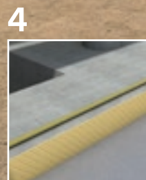
4 SikaFuko® VT hadička pre injektáž
