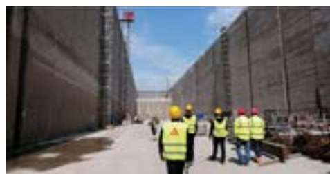
OPRAVA A OCHRANA BETÓNU
