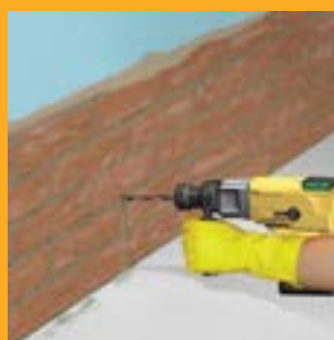
Navíťajte otvory s priemerom 12 mm vodorovne s osovou vzdialenosťou nie väčšou ako 120 mm. Hĺbka otvorov závisí od hrúbky muriva.
