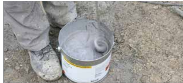
■ 1. Rozmiešanie systémového lepidla Sika®
