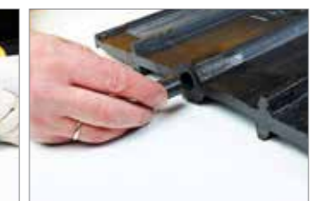
Upchatie stredového vyl'ahčenia penovou zátkou a vloženie zátky zo surovej gumy
