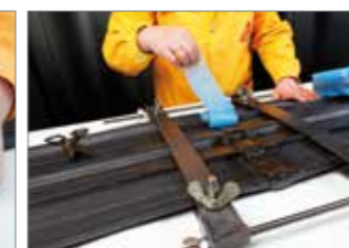
Spájanie tesniaceho pásu, zovretie pomocou fixačných svoriek
