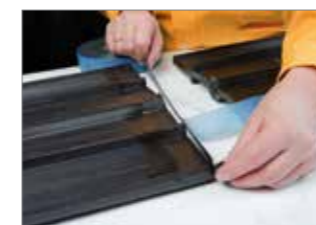
Aplikácia príľnavého pásu
