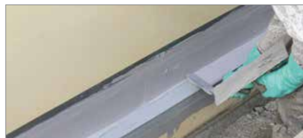
■ 5. Aplikovanie vrchnej vrstvy lepidla
