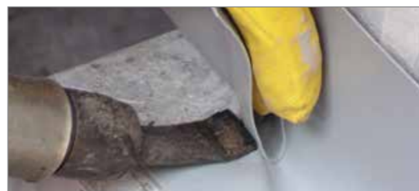
■ 4. Spojenie pásov fólie zvaraním za tepla
