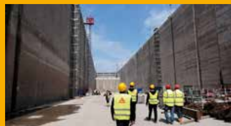
OPRAVA A OCHRANA BETÓNU
