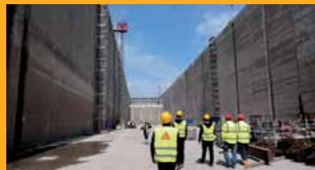
OPRAVA A OCHRANA BETÓNU
