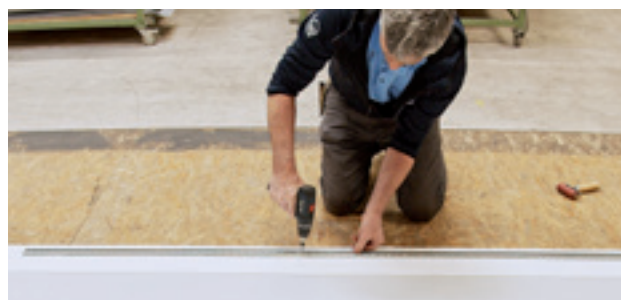
2. Inštalácia kotviacej lišty Sarnabar® s kotviacimi prvkami a zväracou šnúrou Sarnafil® T.
