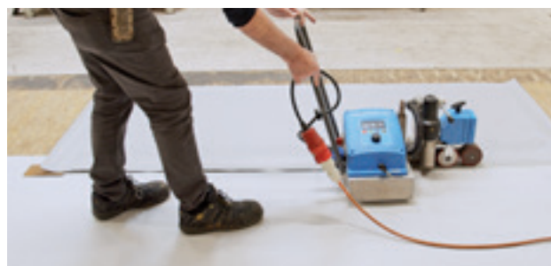
4. Automatické teplovzdušné zváranie fólie Sarnafil® FPO na SikaRoof® MULTITAPE.
