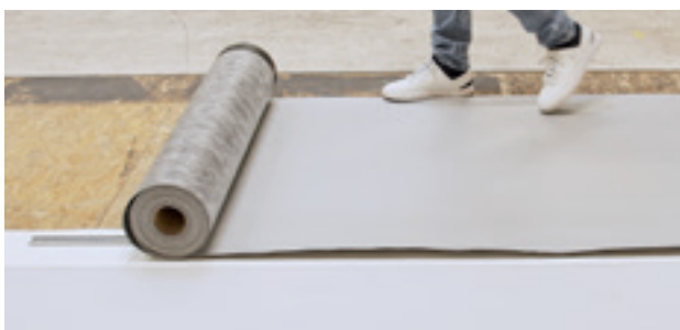
3. Rozvinutie novej hydroizolačnej strešnej fólie Sarnafil® FPO.
