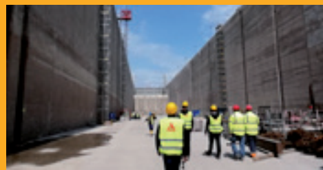
OPRAVA A OCHRANA BETÓNU
