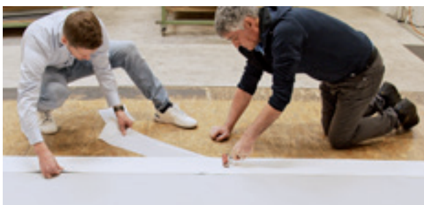
1. Inštalácia SikaRoof® MULTITAPE na existujúcu syntetickú alebo bitúmenovú krytinu.
