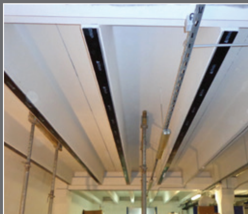
SYSTÉMY NA ZOSILOVANIE NOSNÝCH KONŠTRUKCIÍ
