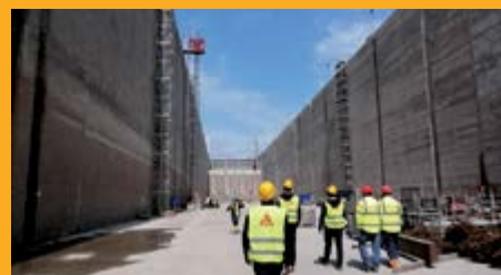
OPRAVA A OCHRANA BETÓNU
