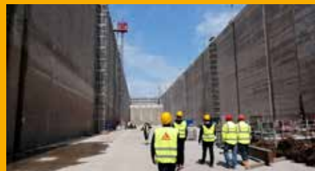
OPRAVA A OCHRANA BETÓNU
