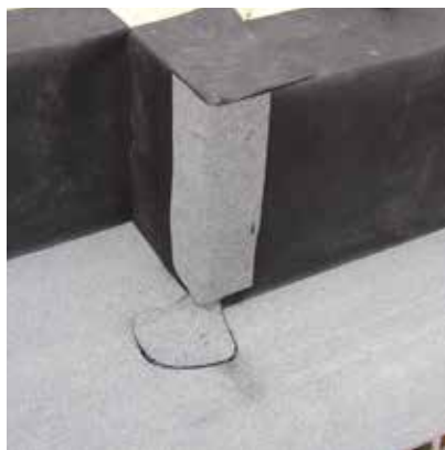
vystuženie vonkajšej zvislej hrany asfaltovým pásom „mineral“
