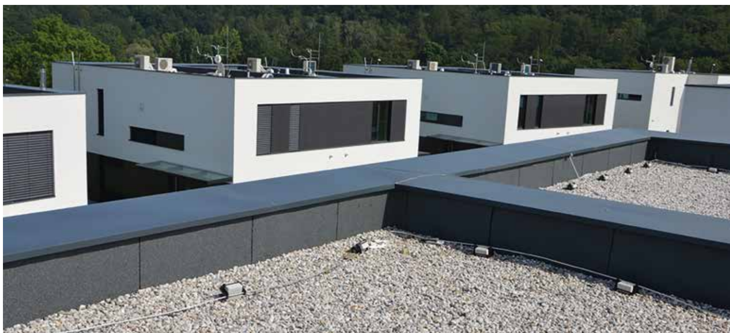
Plaché strechy s modifikovanými asfaltovými pásmi Sika
