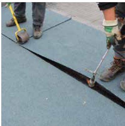
Natavovanie asfaltových pásov. (2. krok, pozdĺžny presah)
