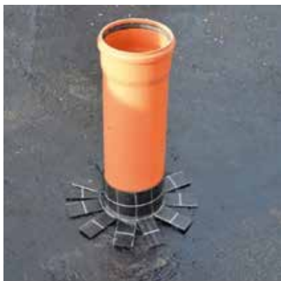
Opracovanie prestupu pri hydroizolácii spodnej stavby.
