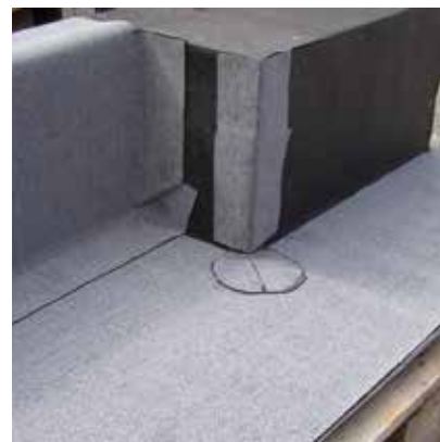
zvislá plocha so zaistením vnútorného rohu
