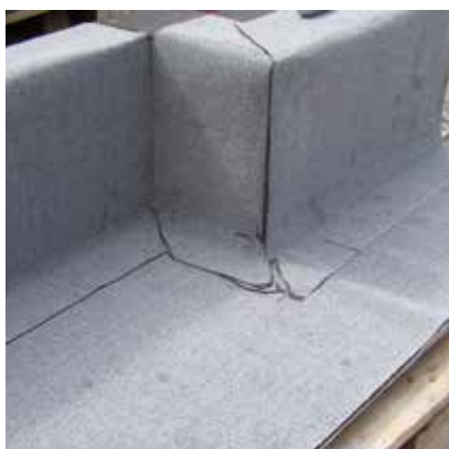
vonkajší aj vnútorný roh je opracovaný spodnými asfaltovými pásmi „mineral“
