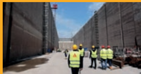
OPRAVA A OCHRANA BETÓNU
