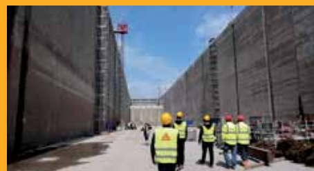
OPRAVA A OCHRANA BETÓNU
