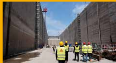
OPRAVA A OCHRANA BETÓNU
