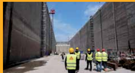
OPRAVA A OCHRANA BETÓNU
