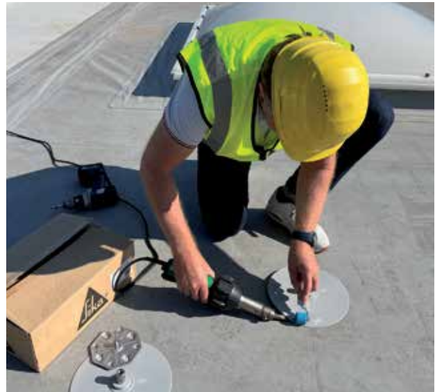
Kotva SikaRoof® 250 mm CR priskrutkovaná ku kotviacej podložke SikaRoof® 140 mm a tepelne privarená k strešnej hydroizolačnej membráne.
