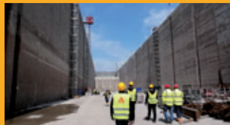
OPRAVA A OCHRANA BETÓNU
