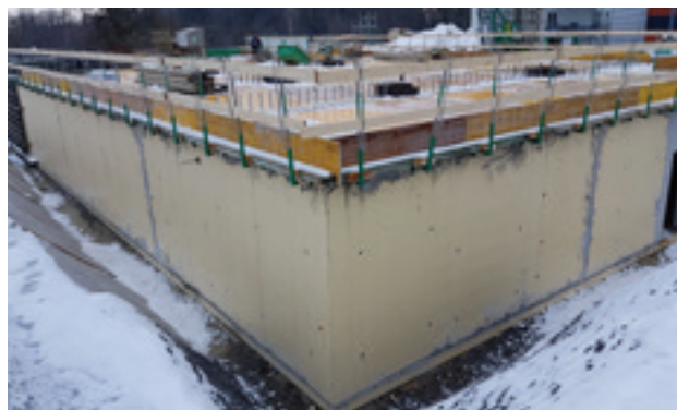
Otvorený výkop s SikaProof® A+, po odstránení debnenia musia byť utesnené otvory prechodu kotiev.
