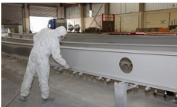
Môže byť aplikovaný na stavenisku alebo v dielni.
