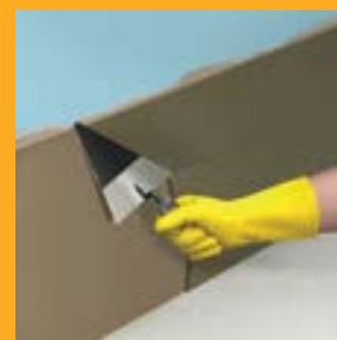
Aplikujte sanačnú omietku SikaMur® Dry
