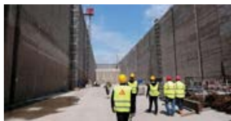
OPRAVA A OCHRANA BETÓNU
