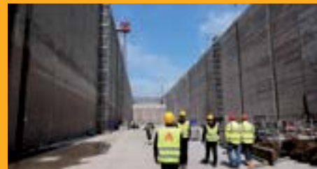
OPRAVA A OCHRANA BETÓNU
