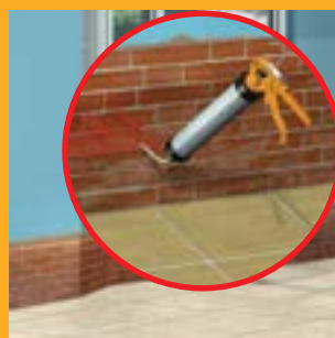
Vsuňte trysku až na dno otvoru. Vytlačajte injektážnu hmotu a zároveň vysúvajte trubicu. Vyplňte otvor až do 1 cm od jeho konca.
