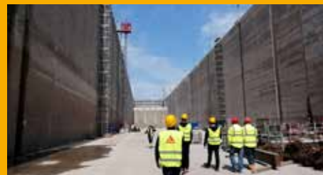
OPRAVA A OCHRANA BETÓNU
