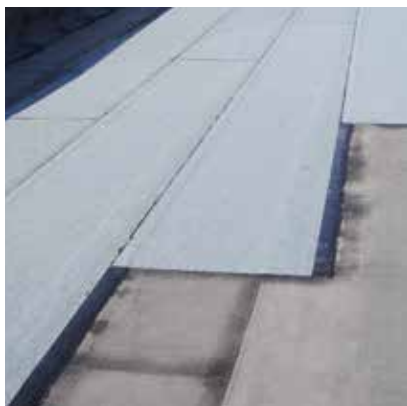
Montáž asfaltových pásov s vystriedanými spojmi.
