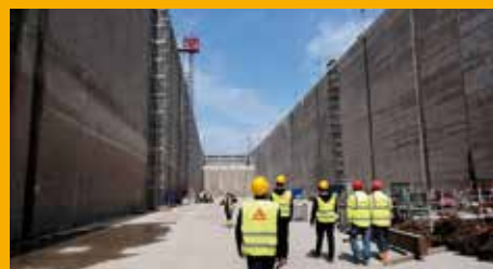
OPRAVA A OCHRANA BETÓNU
