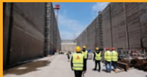
OPRAVA A OCHRANA BETÓNU
