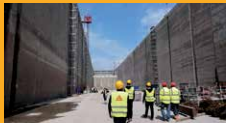
OPRAVA A OCHRANA BETÓNU
