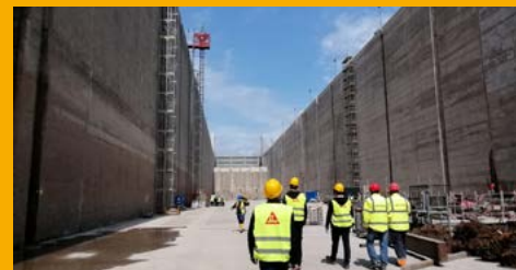
OPRAVA A OCHRANA BETÓNU
