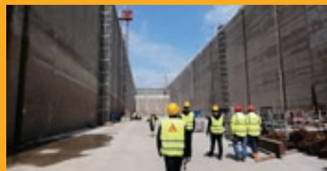
OPRAVA A OCHRANA BETÓNU
