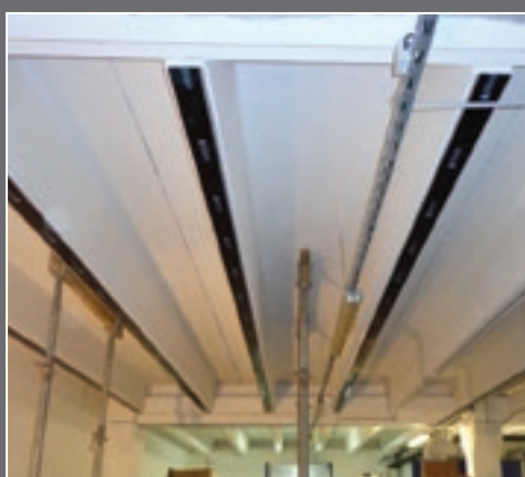
SYSTÉMY NA ZOSILOVANIE NOSNÝCH KONŠTRUKCIÍ
