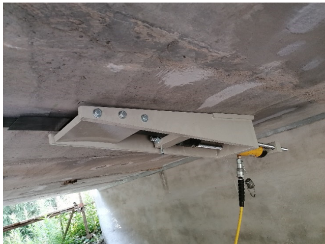
Ukotvenie lamely do aktívnej oceľovej kotvy, pred napínaním pomocou hydraulického zariadenia.
