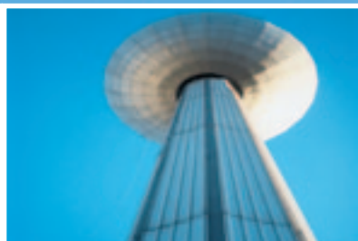
Nádrže na vodu
