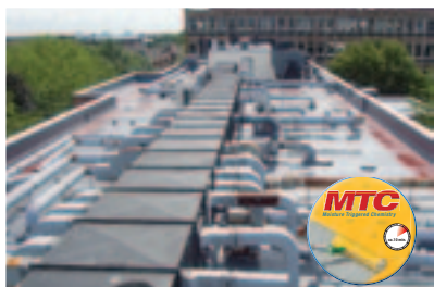
Rekonštrukcie striech pomocou tekutých fólií
