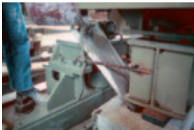
Zalievanie základovej platne stroja
