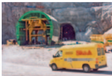
Podpora na stavenisku
