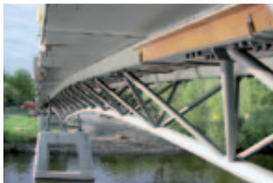
Lepenie nosných prvkov mosta
