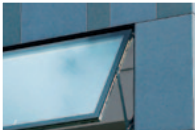
Lepenie okna v konštrukcii
