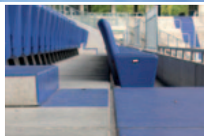
Dilatačné škára na podlahe
