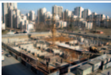
Výroba betónu priamo na stavenisku
