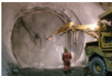
Aplikácie striekaného betónu
