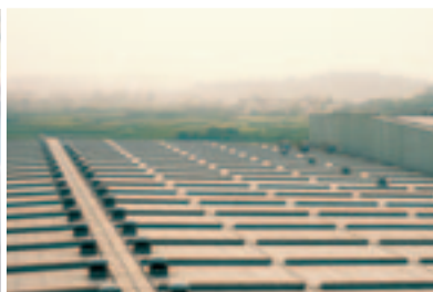
Ploché strechy na priemyselných budovách
