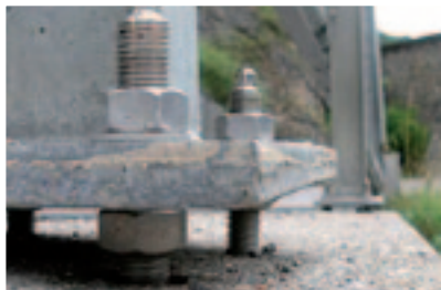
Ukotvenie; uchytenie závitových tyčí a roxorov
