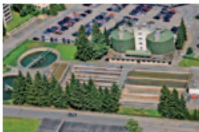
Čistiarne odpadových vôd
