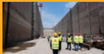
OPRAVA A OCHRANA BETÓNU
