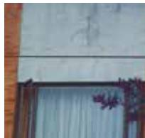
Odolnosť voči vode je výrazne obmedzená na stenách s veľkými trhlinami.
