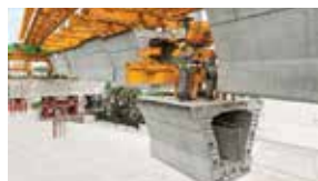
Concrete / Výroba betónu
