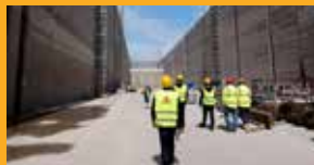
OPRAVA A OCHRANA BETÓNU
