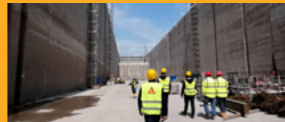
OPRAVA A OCHRANA BETÓNU
