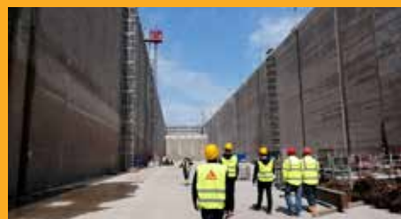
OPRAVA A OCHRANA BETÓNU
