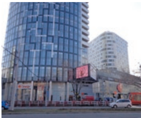
Centrál, Bratislava, Sika CarDeck systémy – 35.000 m 2
