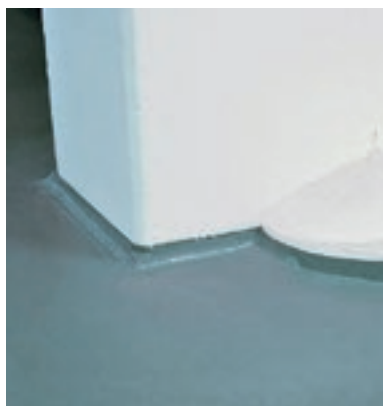
FABIÓN S VYTIHNUTÍM OKOLO STĹPOV, V MIESTE STYKU PODLAHA - STENA, PRI SCHODOCH
