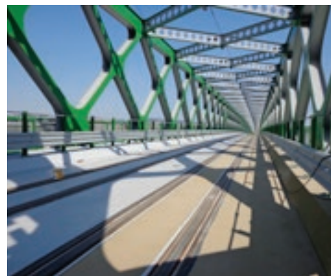
Nosný systém MHD, Vozovka na moste, Sika CarDeck systémy – 4.000 m 2
