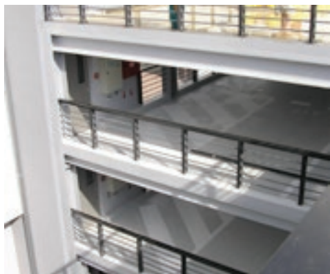
Parkovací dom Vered, Bratislava, Sika CarDeck systémy – 7.000 m 2
