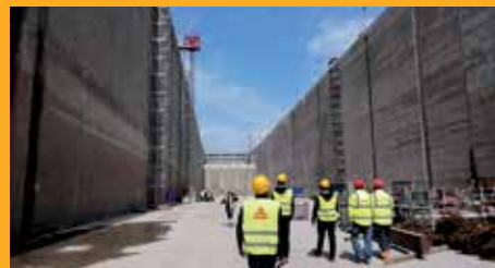
OPRAVA A OCHRANA BETÓNU
