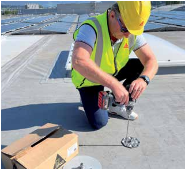
Upevňovací prvok Sarnafast® SBF-6.0 alebo Sarnafast® SBF-6.0 so Sarnabar® Tube SBT-20.
