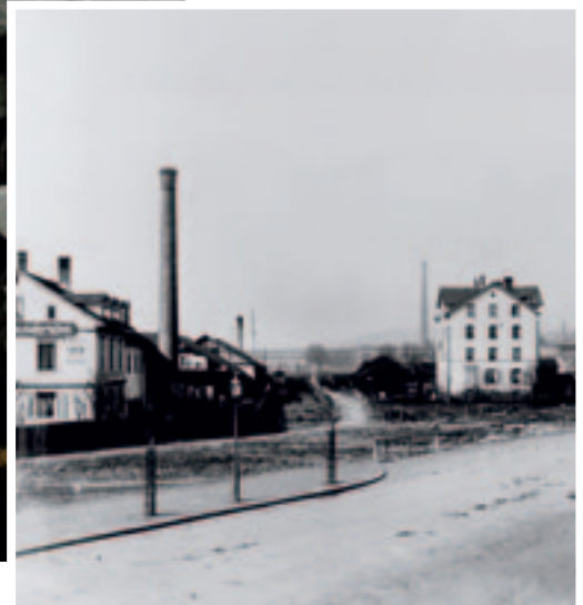
Prvý výrobný závod v Zurichu na Neugasse 99 v blízkosti hlavnej železničnej stanice.
