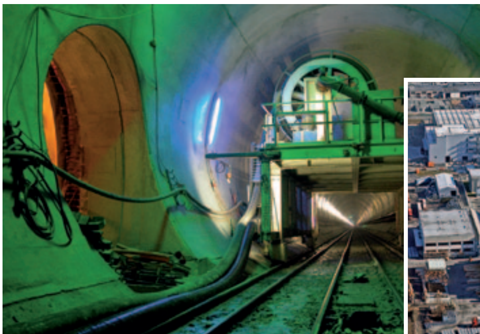
Nový 57 km dlhý Gotthardov tunel je znova dôležitým projektom Sika. Hoci je Sika-1 stále súčasťou nášho sortimentu, tentoraz bolo použitých množstvo nových, moderných výrobkov.
