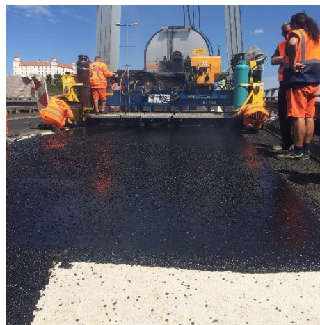
Aplikácia liateho asfaltu na hydroizolačnú vrstvu
