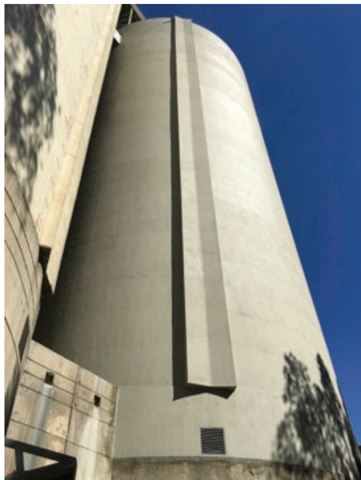
Po opravných prácach.
