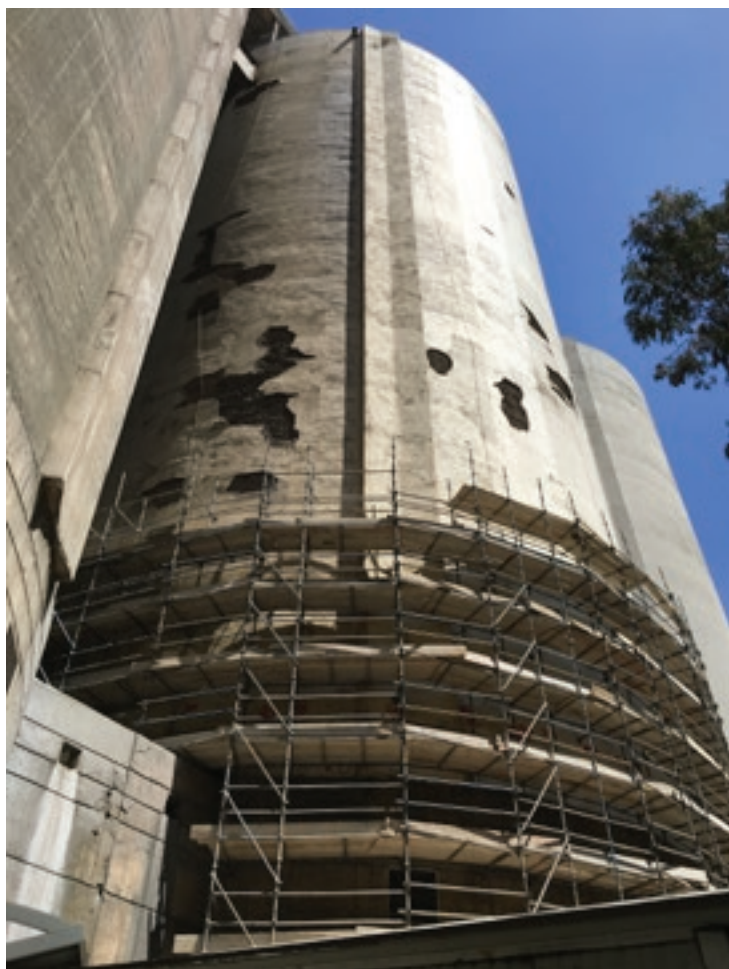
Pred opravnými prácami.
